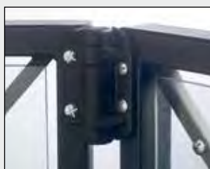
Paumelle haute à fermeture automatique
